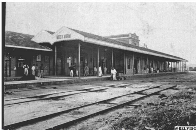
Estação de Mogi Mirim, lado da plataforma, anos 1910.
