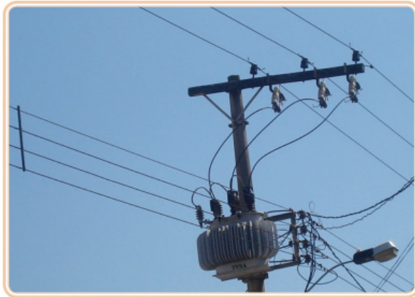
Redes de alta tensão, de baixa tensão e o transformador
