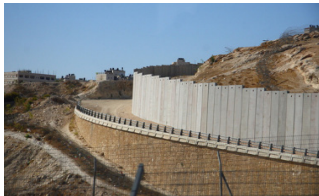
Imagem do Muro de Israel, na Cisjordânia
